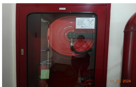
ตู้สายฉีดน้ำพร้อมอุปกรณ์
